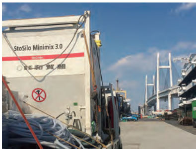
コンクリート補修事業(本牧ふ頭、横浜市港湾局)
