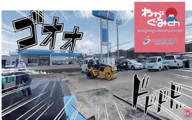
【目撃せ土木女子】舗装屋さんに挑戦！土木工事おもしろっ
